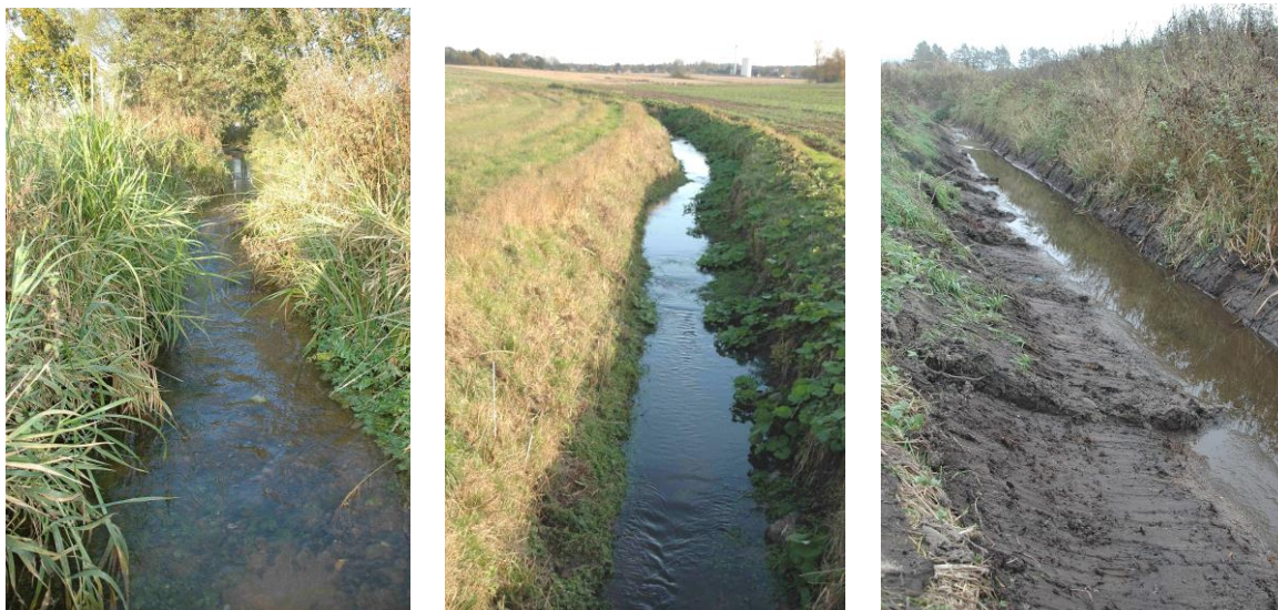
Foto 1. Grader af vandløbsvedligeholdelse (fra venstre): Nænsom skæring i strømrønde med bevareret udhæng. Omfattende skæring af udhæng i fuld bredde og til højre oprenset vandløb, hvor grundlaget for liv er væk.
