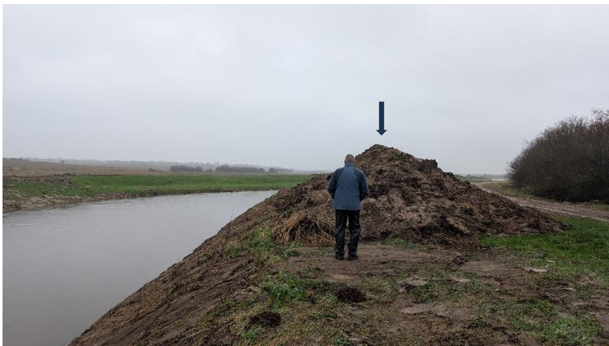
Opgravede mængder er mange kubikmeter, vist ved den blå pil. Billedet er taget lige nedstrøms Elhjemvej.
