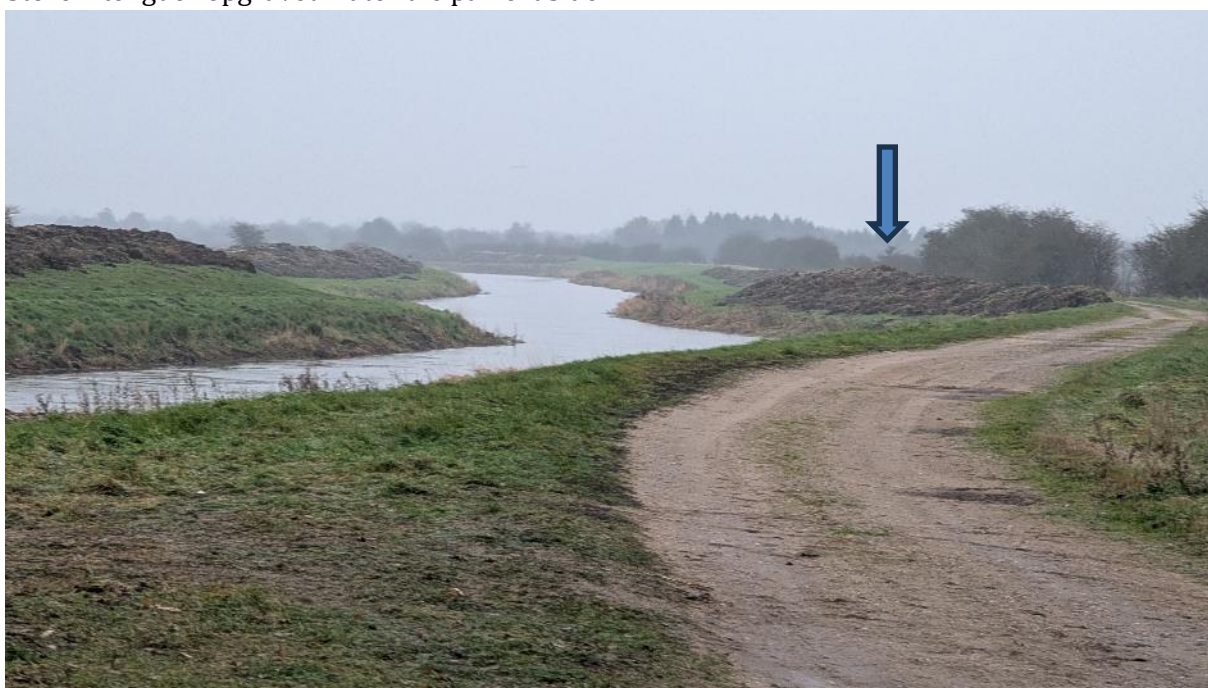
Opgravet materiale på sydsiden
