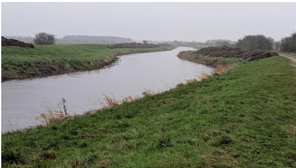
Store mængder opgravet materiale langs åen
